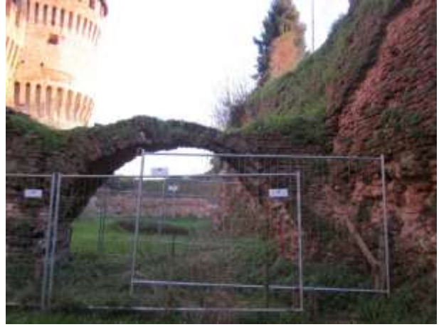
Ponte di Fuga. Il dissesto statico in atto riguardante la riduzione di sezione dell'arcata ovest ed il degrado del manufatto ricoperto dalla vegetazione infestante.
