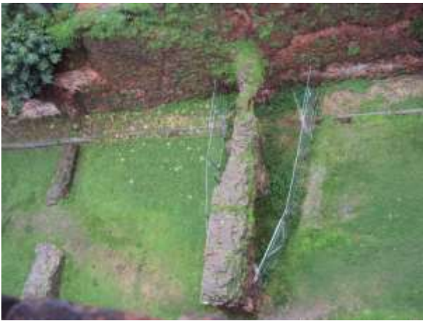
Ponte di Fuga. Il dissesto statico in atto riguardante la riduzione di sezione dell'arcata ovest ed il degrado del manufatto ricoperto dalla vegetazione infestante.
