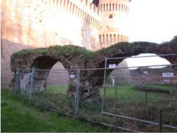
Ponte di Fuga. Il dissesto statico in atto riguardante la riduzione di sezione dell'arcata ovest ed il degrado del manufatto ricoperto dalla vegetazione infestante.
