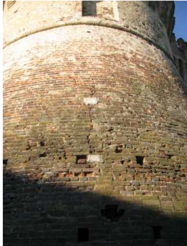
Torre Cilindrica. Fessura visibile sul paramento murario esterno
