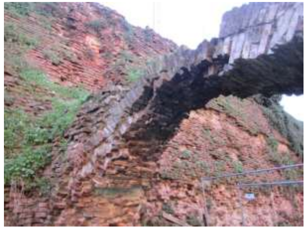
Ponte di Fuga. Il dissesto statico in atto riguardante la riduzione di sezione dell'arcata ovest ed il degrado del manufatto ricoperto dalla vegetazione infestante.
