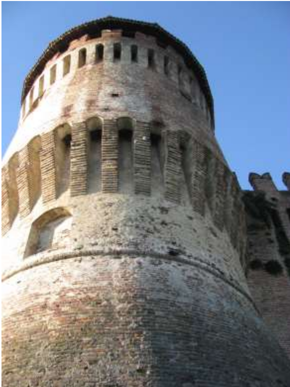
Torre Cilindrica. Fessura visibile sul paramento murario esterno
